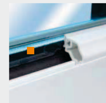
Verbund-Sicherheitsglas im Flügel verklebt. Eine Investition, die sich rechnet, da durch die Verbund-Sicherheits-scheibe auch ein verbesserter Schallschutz gegeben ist.
